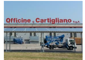
หลังคาที่จอดรถ
